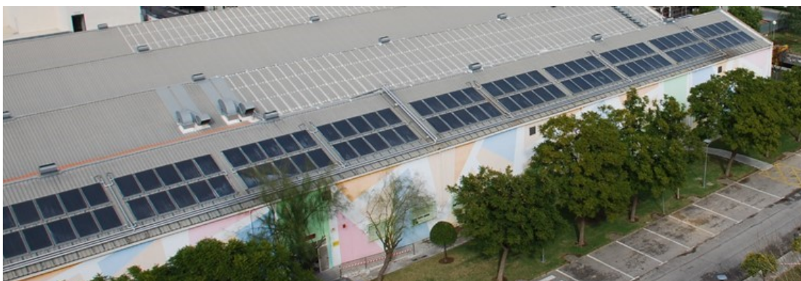
Figura 39: Ejemplo de modulación en baterías y superposición en cubierta de captadores solares
