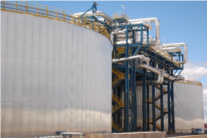
Abbildung 1: Flüssigsalzspeicher in einem solarthermischen Kraftwerk (Bildquelle Andasol 3)
