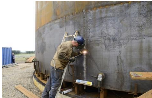
Слика 43: Инсталација на челични резервоари во систем за централно греење во Хјалеруп. Лево: Инсталација на два резервоара поврзани со когенеративна постројка. Десно: Инсталација на нов резервоар поврзан со соларни термални колектори и котел на слама. Повеќе за системот за централно греење во Хјалеруп во извештајот за најдобри практики на Лауберг Јенсес и др. (2016) (Извор: www.hjallerupfjernvarme.dk )
