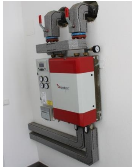
Слика 55: Топлотна потстанција со топлински изменувач, контролна единица, вентили и мерна опрема (лево) (Извор: Güssing Energy Technologies) и топлотна потстанција со топлински изменувач за краен потрошувач во Ахентал, Германија (десно) (Извор: Rutz)
