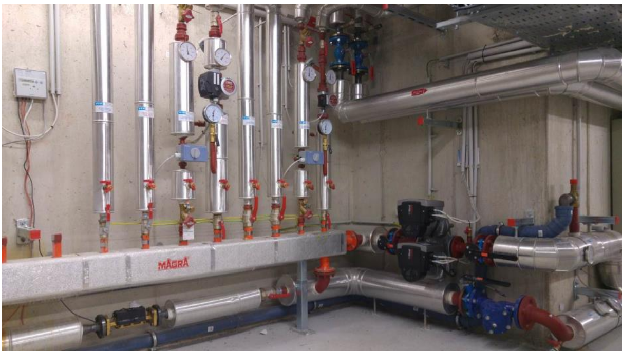
Слика 58: Дистрибуција на топлинска енергија во деловна зграда поврзана на систем за централно греење (Извор: Güssing Energy Technologies)
