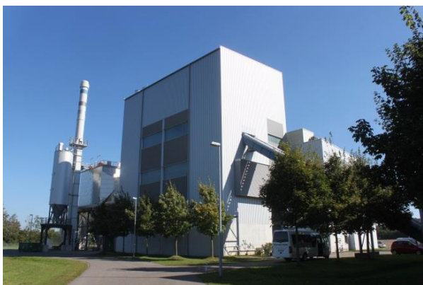
Слика 19: Когенеративна постројка на дрвен чипс и нејзината парна турбина во Штадверке Аугзбург Енерги, Германија (капацитет: 80 000 t/годишно дрвен чипс; 7,8 MW el ; 15 MW th ) (Извор: Rutz D.)
