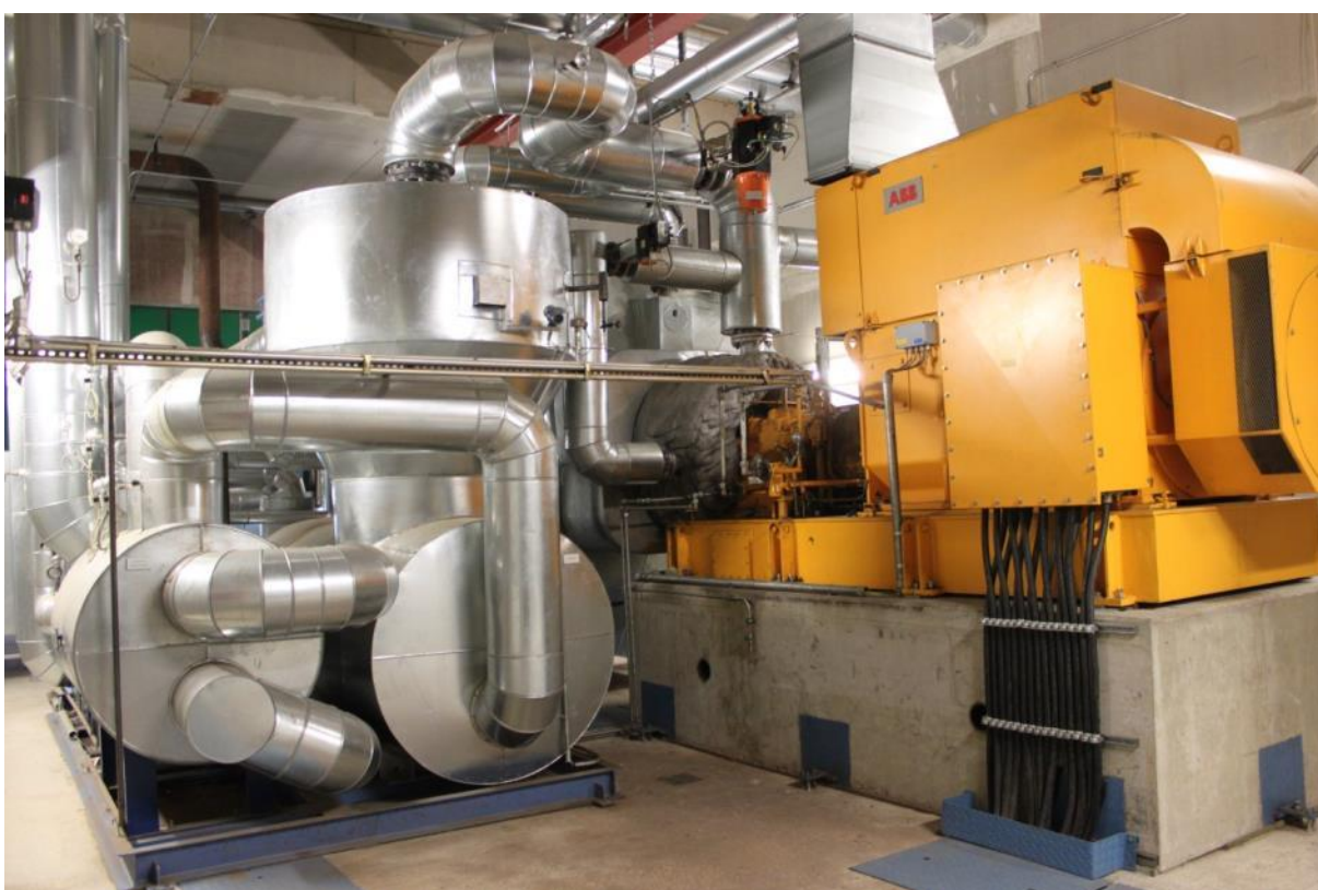
Слика 20: ORC систем (1520 kW el ) во Грундфутертрокунгзгеносеншафт Кирхдофт, Германија (Извор: Rutz D.)
