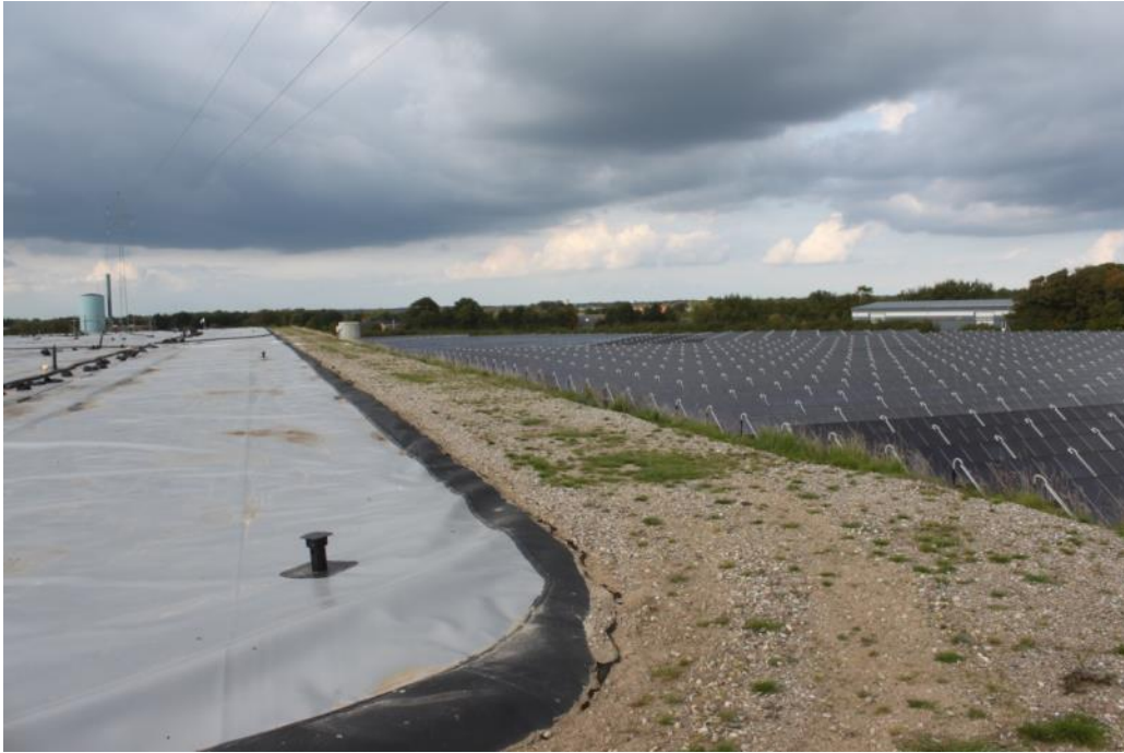
Слика 45: Раб на резервоар во облик на јама заедно со соларни термални колектори интегрирани во систем за централно греење, Грам, Данска (Извор: Rutz D.)
