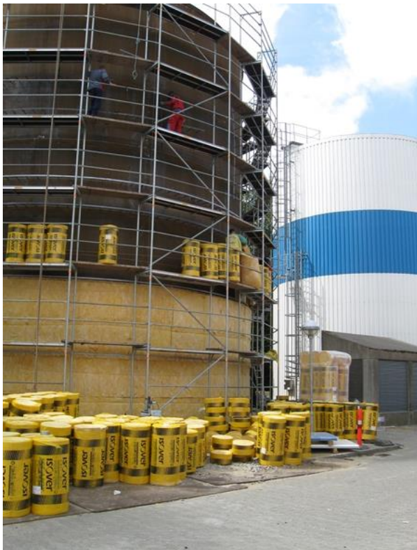
Слика 43: Инсталација на челични резервоари во систем за централно греење во Хјалеруп. Лево: Инсталација на два резервоара поврзани со когенеративна постројка. Десно: Инсталација на нов резервоар поврзан со соларни термални колектори и котел на слама. Повеќе за системот за централно греење во Хјалеруп во извештајот за најдобри практики на Лауберг Јенсес и др. (2016) (Извор: www.hjallerupfjernvarme.dk )
