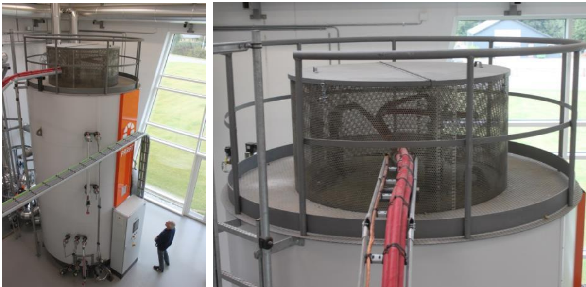
Слика 33: Електричен бојлер со моќност од 10 MW и капацитет од 14,4 m 3 поврзан со соларен систем за греење во Грам, Германија (Извор: Rutz D.)
