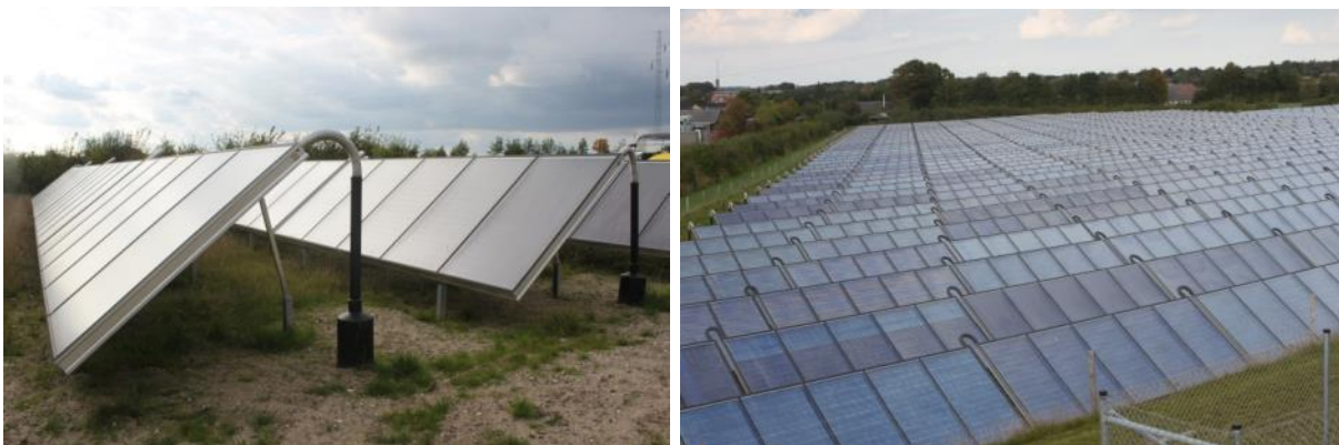
Слика 8: Колектори со рамна плоча поставени на земја во системот за централно греење во Грам, Данска (Извор: Rutz D.)
