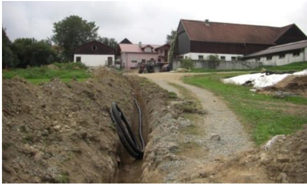
Слика 52: Положување на цевки во земјата (Извор: Thermaflex Isolierprodukte GmbH) Слика 53: Машина за бушење (Извор: Rutz)
