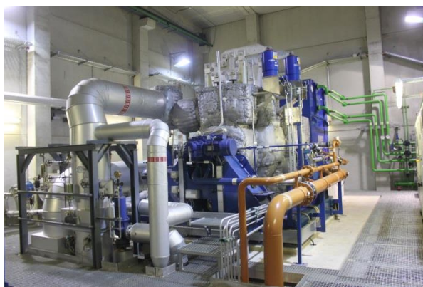
Слика 19: Когенеративна постројка на дрвен чипс и нејзината парна турбина во Штадверке Аугзбург Енерги, Германија (капацитет: 80 000 t/годишно дрвен чипс; 7,8 MW el ; 15 MW th ) (Извор: Rutz D.)
