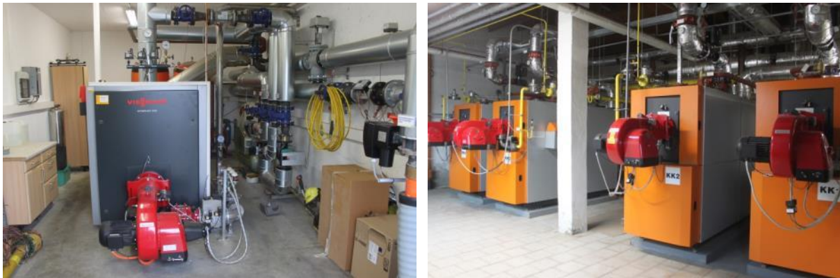
Слика 40: Котел на нафта за задоволување на врвната потрошувачка, Германија (лево) и котел на природен гас (десно) во постројка на биомаса, Р. Чешка (Извор: Rutz D.)
