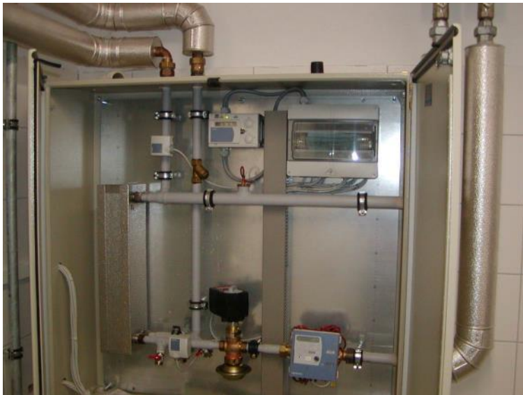
Слика 55: Топлотна потстанција со топлински изменувач, контролна единица, вентили и мерна опрема (лево) (Извор: Güssing Energy Technologies) и топлотна потстанција со топлински изменувач за краен потрошувач во Ахентал, Германија (десно) (Извор: Rutz)
