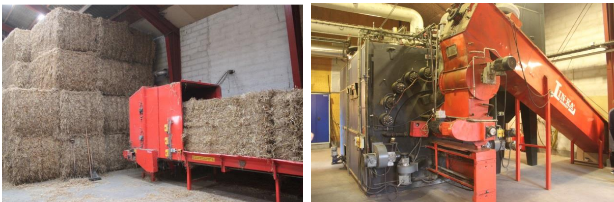
Слика 17: Додавање на бали од слама (лево) и 1,6 MW котел за согорување на слама (десно) во Бален-Брандби, Германија (Извор: Rutz D.)
