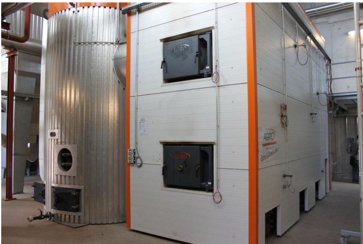
Слика 16: Систем за греење со дрвен чипс, средна големина (капацитет од 3000 kW) со котел (десно) и бафер резервоар (лево) во Биомасенхоф Ахентал, Германија (Извор: Rutz D.)
