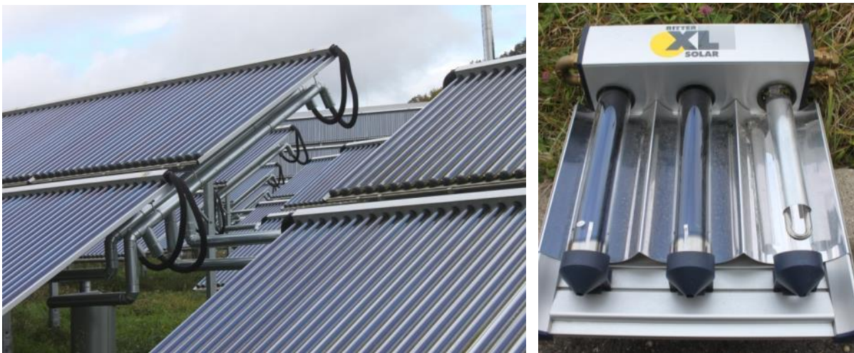
Слика 7: Колектори со вакуумски цевки поставени на земја во системот за централно греење во Бусинген, Германија (лево) и примерок од колекторите (десно) каде се гледа U формата на цевководот на десната цевка, како и параболичниот концентратор под цевките (Извор: Rutz D.)
