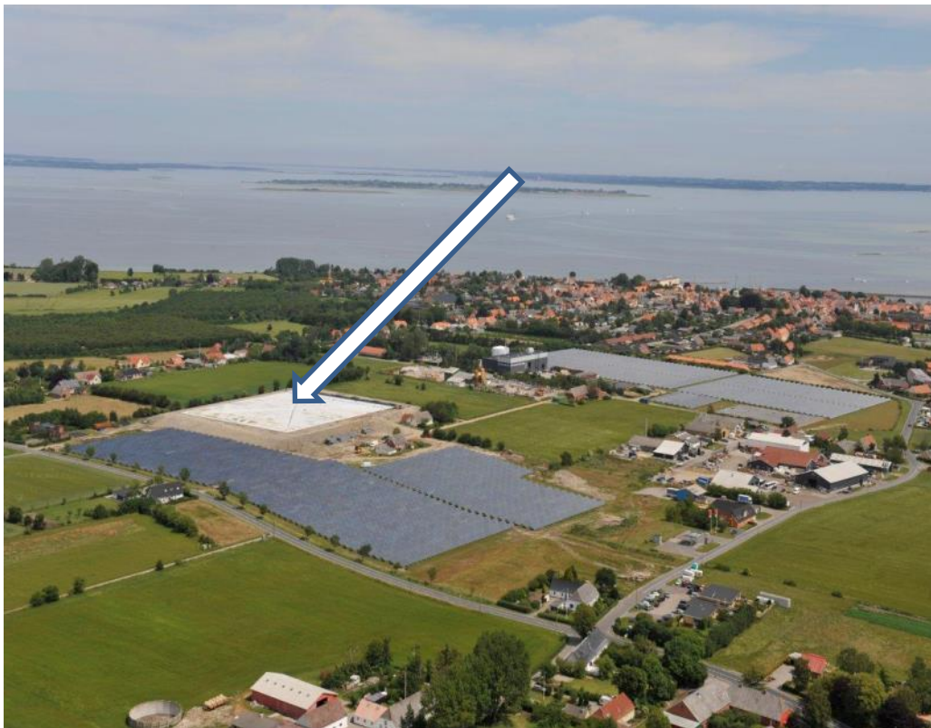
Слика 44: Резервоар во облик на изолирана јама, Мастрал, Данска (Извор: PlanEnergi)
