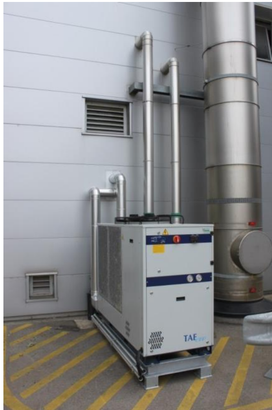
Слија 68: Чилер ладен со воздух кој користи отпадна топлина од постројка за согорување во Австрија (Извор: Rutz D.)
