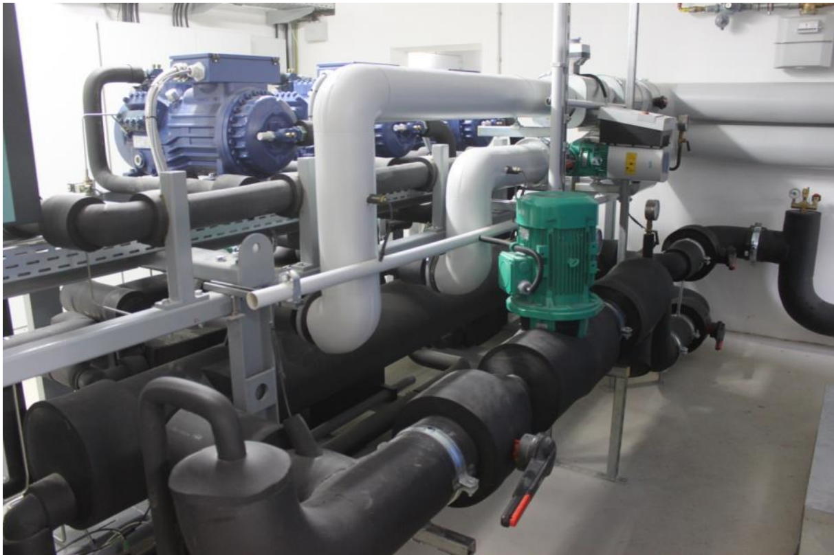
Слика 34: Топлинска пумпа со моќност од 440 kW која ја апсорбира топлината од подземните води, а снабдува мал систем за централно греење во Долштајн, Германија (Извор: Rutz D.)
