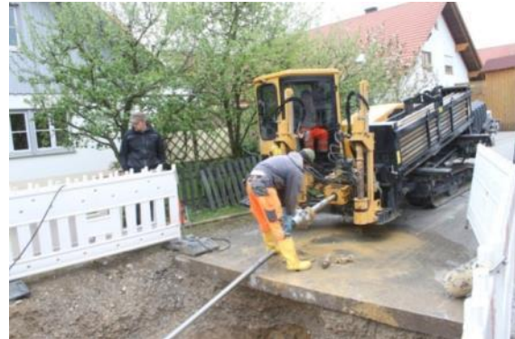
Слика 52: Положување на цевки во земјата (Извор: Thermaflex Isolierprodukte GmbH) Слика 53: Машина за бушење (Извор: Rutz)
