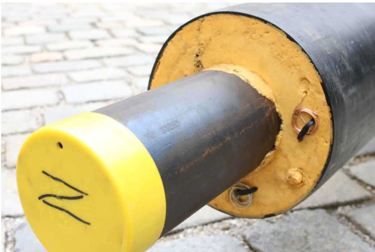
Слика 51: Единечна челична цевка со две жици кои се дел од системот за предупредување (Извор: Rutz D.)
