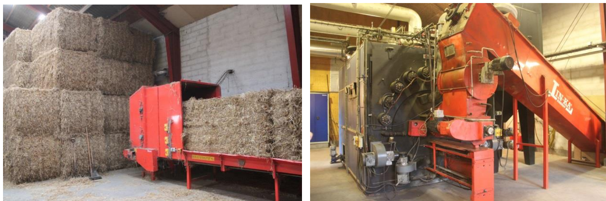
Slika 17. Sustav za dobavu bala slame (lijevo) te kotao na slamu snage 1,6 MW u Ballen-Brundbyu, Danska (Izvor: Rutz D.)
