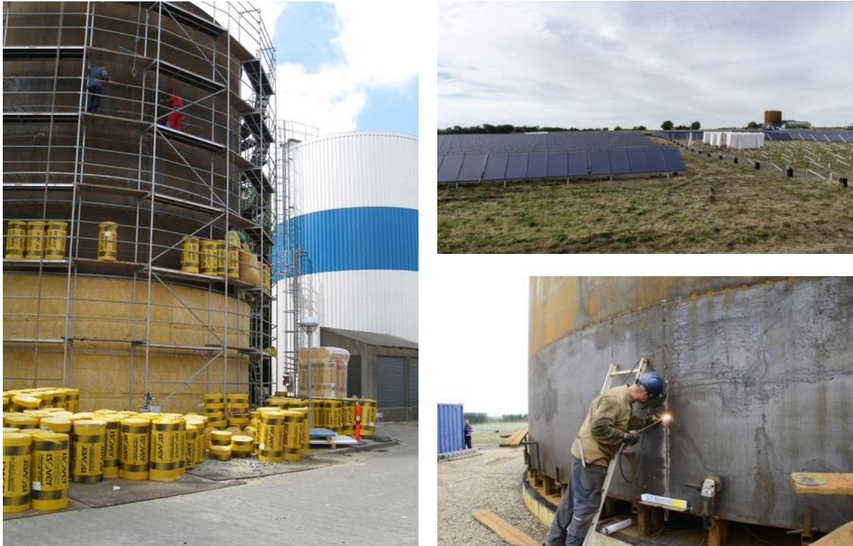
Slika 43. Izgradnja dva nova toplinska spremnika u obliku čeličnog tanka u CTS-u Hjallerup (lijevo) i izgradnja iste vrste spremnika topline povezanog sa sunčevim kolektorima i kotlom na slamu. Više o CTS-u u Hjallerupu se može saznati u izvještaju o primjerima najbolje prakse Laurberg Jensen et al.(2016) (Izvor: http://www.hjallerupfjernvarme.dk )
