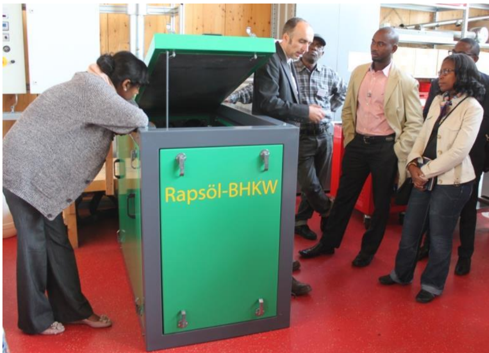
Slika 28. CHP postrojenje koje koristi ulje od uljane repice (Izvor: Rutz D.)
