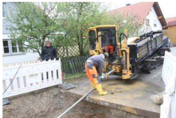
Slika 53 Uređaj za usmjereno bušenje (Izvor: Rutz D.)
