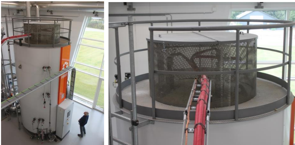
Slika 33. Električni bojler instalirane snage 10 MW te kapaciteta 14,4 m 3 koji se nalazi u gradu Gram (Danska) te je spojen na CTS (Izvor: Rutz D.)
