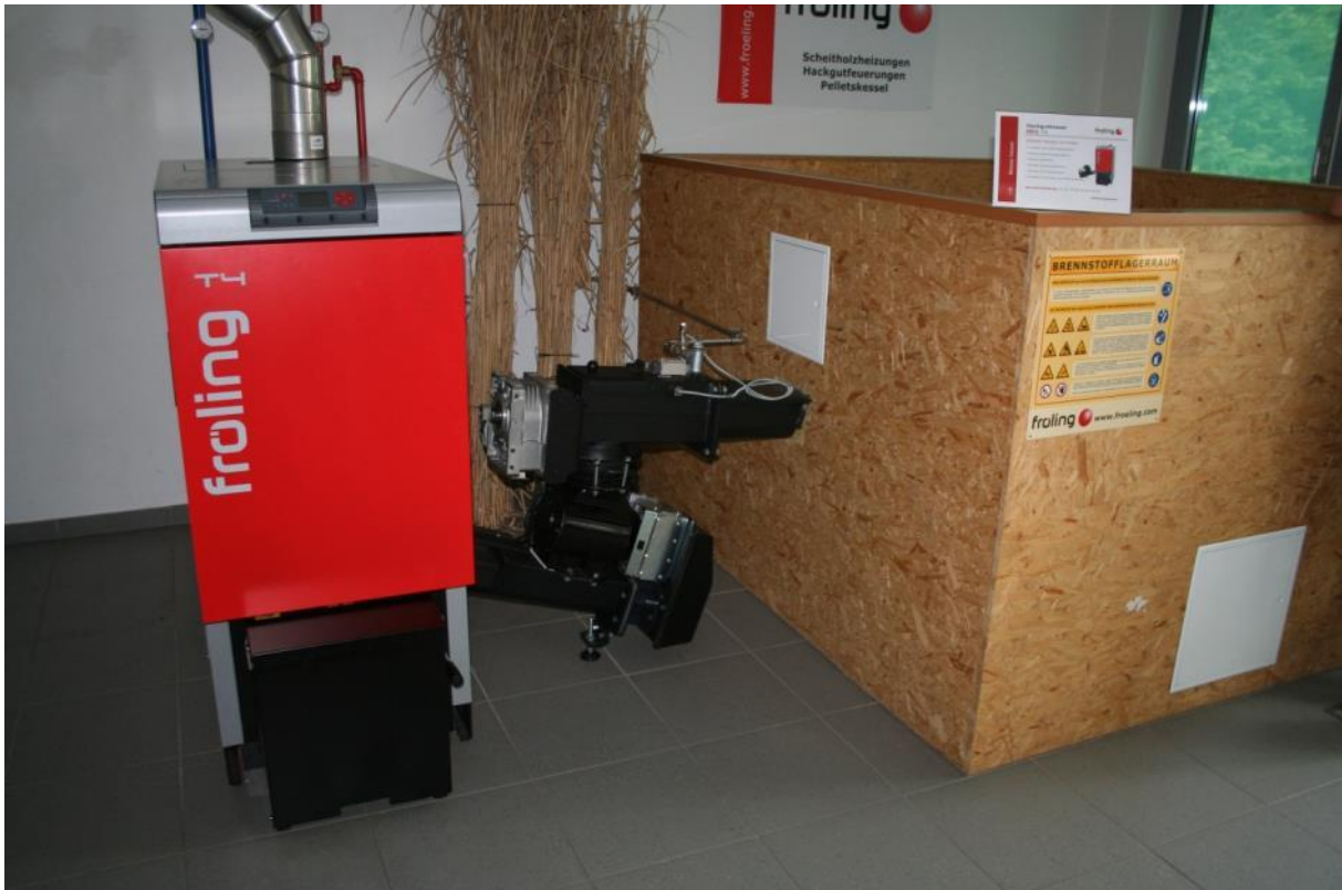
Slika 15. Mali sustav grijanja koji koristi drvenu sječku (instalirana snaga 24-50 kW) sa kotlom (lijevo), sustavom za dobavu biomase (sredina) i spremnikom drvene sječke (desno) u Frölingu (Izvor: Rutz D.)
