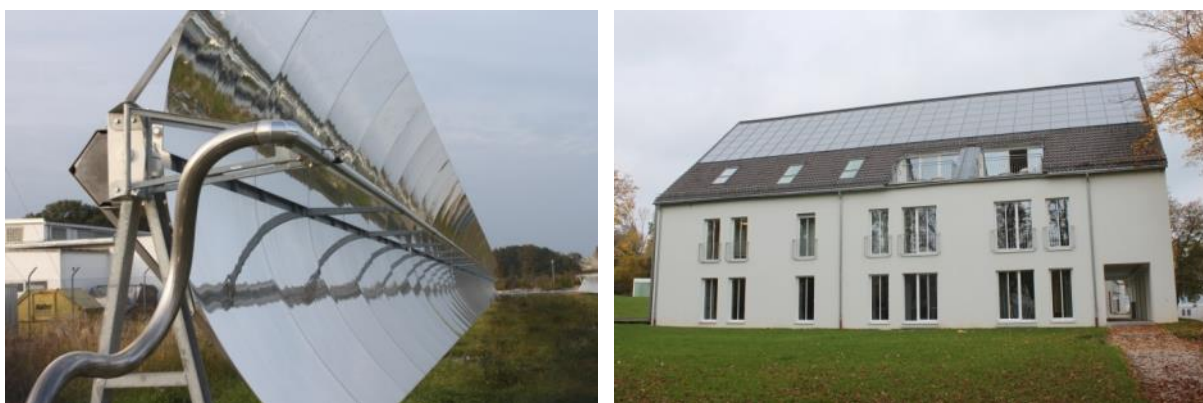
Slika 9. Probno postrojenje koje koristi parabolni kolektore (lijevo) te sunčevi kolektori postavljeni na krov zgrade kao dio malog CTS-a u Bad Aiblingu u Njemačkoj (Izvor: Rutz D.)
