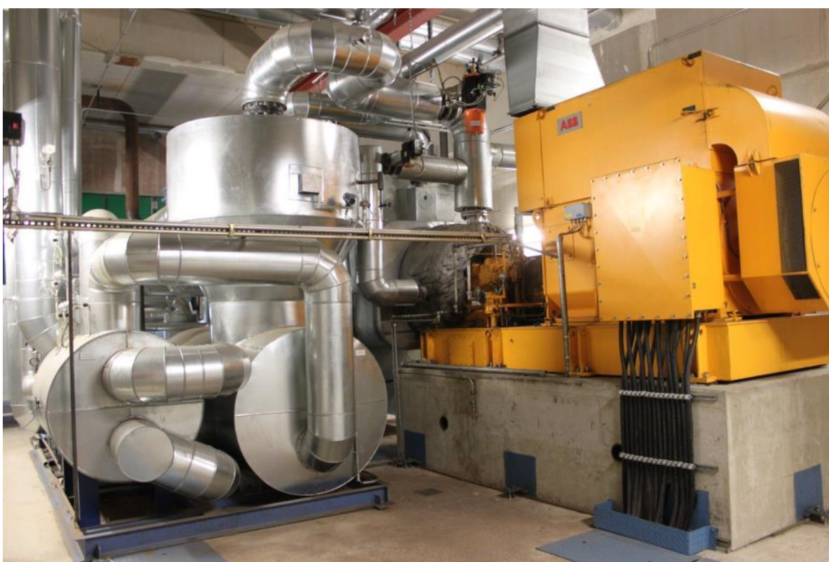
Slika 20. ORC sustav (1 520 kW el ) u Grünfüttertrocknungsgenossenschaft Kirchdorf a.H. eG u Njemačkoj (Izvor: Rutz D.)
