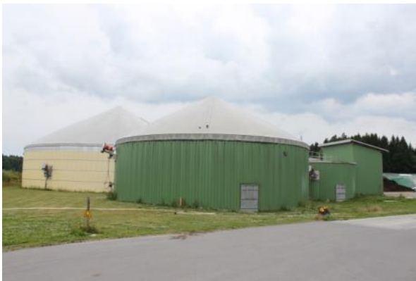
Slika 23. Digestori poljoprivrednog bioplinskog postrojenja (lijevo) i CHP jedinica (desno) bioplinskog postrojenja (Izvor: Rutz D.)
