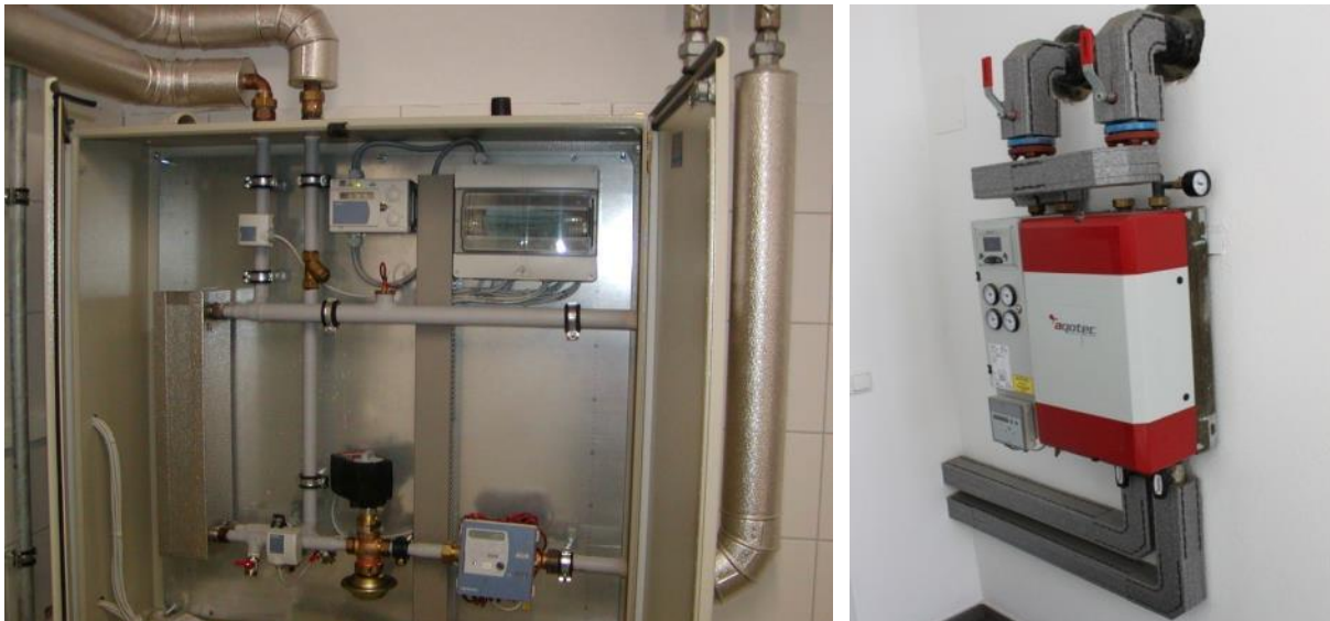
Slika 55. Toplinska podstanica sa izmjenjivačem topline, regulacijskim uređajem, ventilima i kalorimetrom (lijevo) (Izvor: Güssing Energy Technologies) te toplinska podstanica (uključujući izmjenjivač topline) krajnjeg potrošača u Achentalu, Njemačka (Izvor: Rutz D.)
