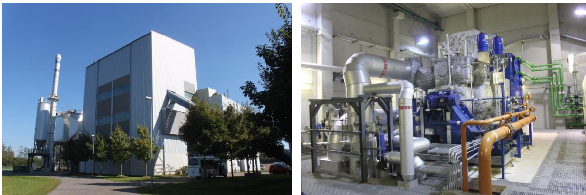
Slika 19. Kogeneracijsko postrojenje na drvenu sječku te parna turbina postrojenja Stadtwerke Augsburg Energie GmbH u Njemačkoj (kapacitet 80 000 t/god drvene sječke; 7,8 MW el ; 15 MW th ) (Izvor: Rutz D.)
