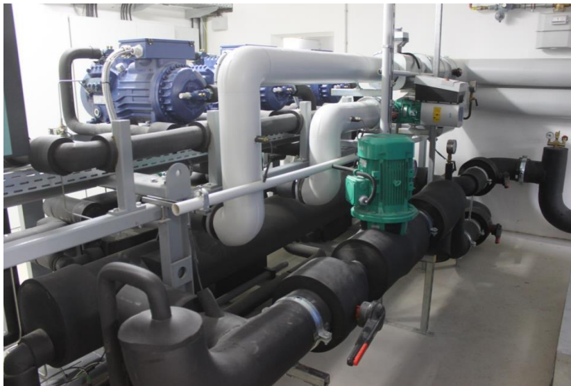
Slika 34. Dizalica topline koja koristi podzemne vode kao izvor topline (instalirana snaga 440 kW) u malom CTS sa sunčevim kolektorima u Dollnsteinu, Njemačka (Izvor: Rutz D.)
