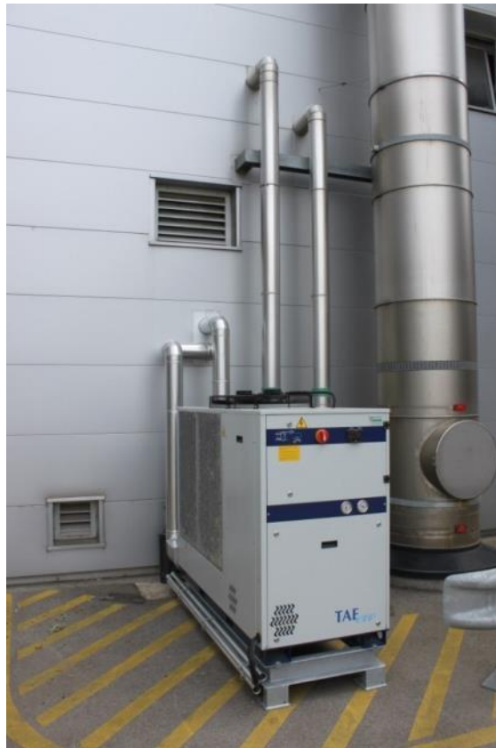
Slika 68. Hladnjak hlađen zrakom koji koristi otpadnu toplinu postrojenja za spaljivanje otpada u Austriji (Izvor: Rutz D.)
