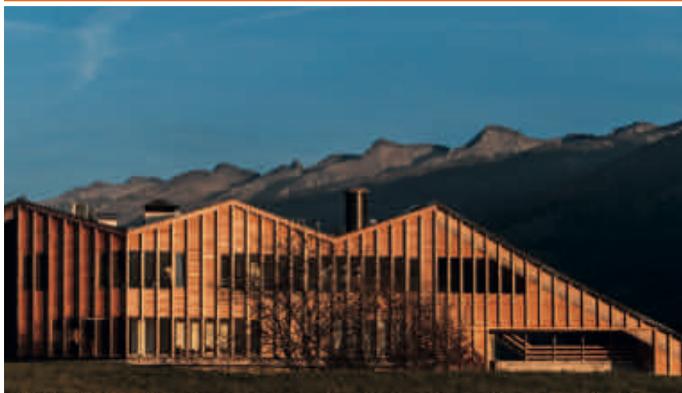
Impianto di teleriscaldamento, Comune di Cavalese (TN)
