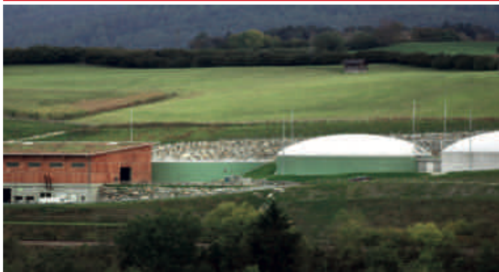
Impianto biogas Comune di San Lorenzo (BZ)
