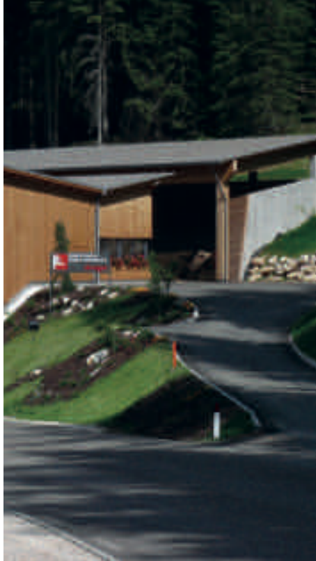
Impianto di teleriscaldamento, Comune di Oberstein (BZ)
