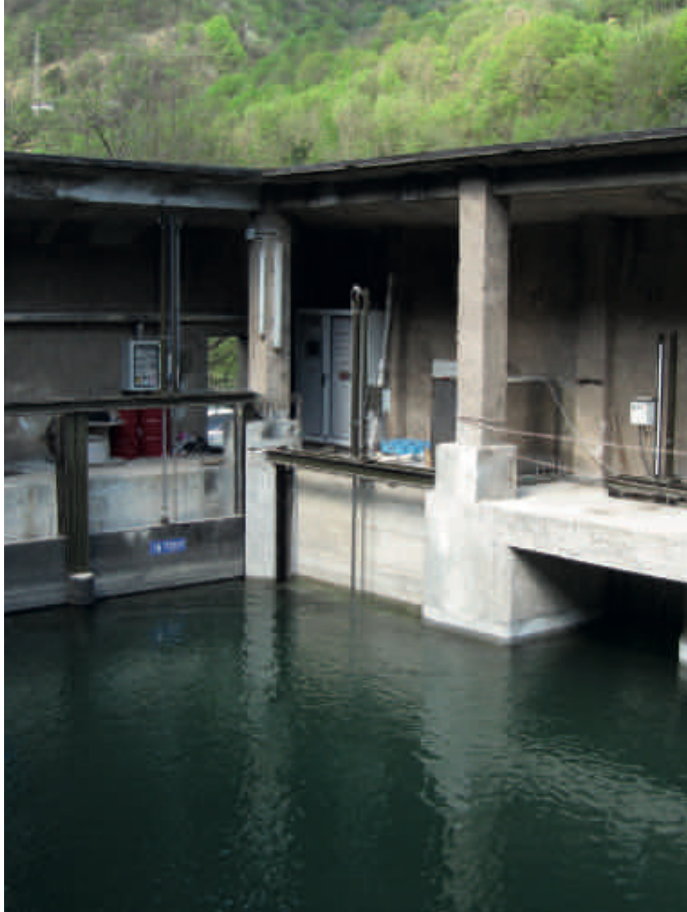
Impianto idroelettrico, Comune di Brunico (BZ)
