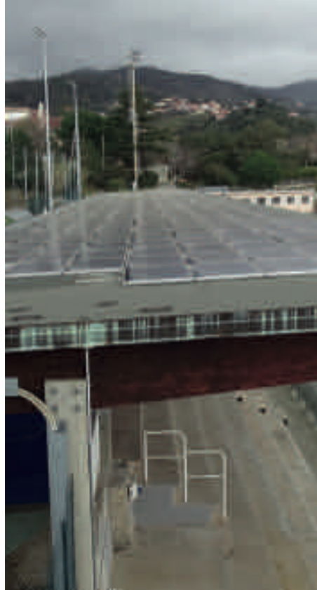
Gradinate, Comune di Celle Ligure (SV)
