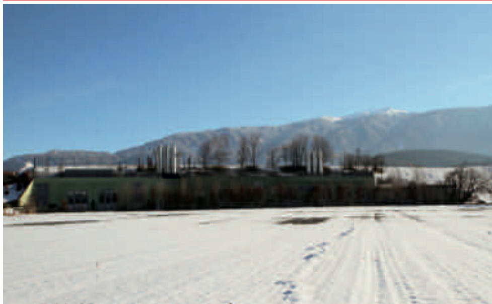
Centrale di teleriscaldamento, Comune di Brunico (BZ)
