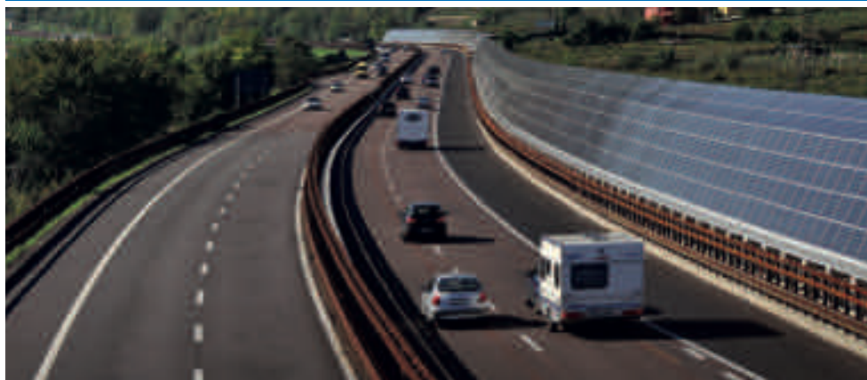
Pannello fonoassorbente fotovoltaico, Comune d'Isera (TN)
