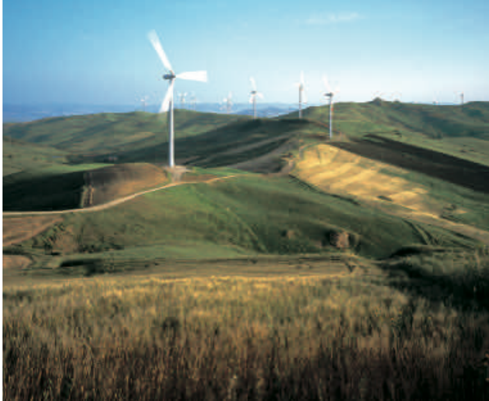
Impianto eolico, Comune di Raddusa (CT)
