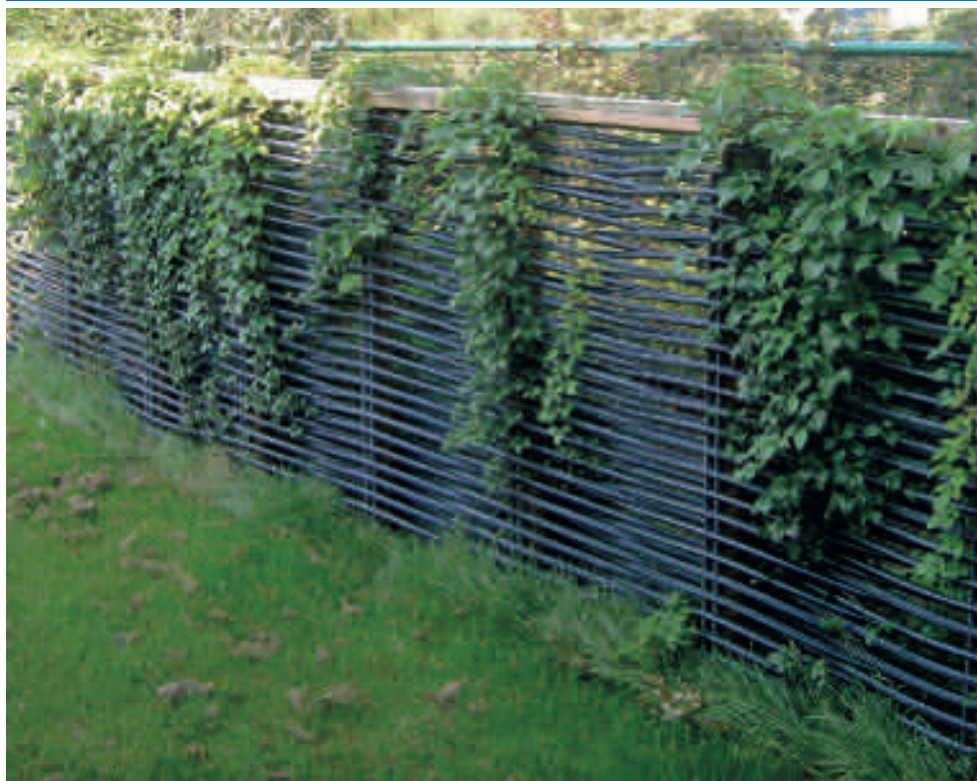
Impianto geotermico a palizzata
