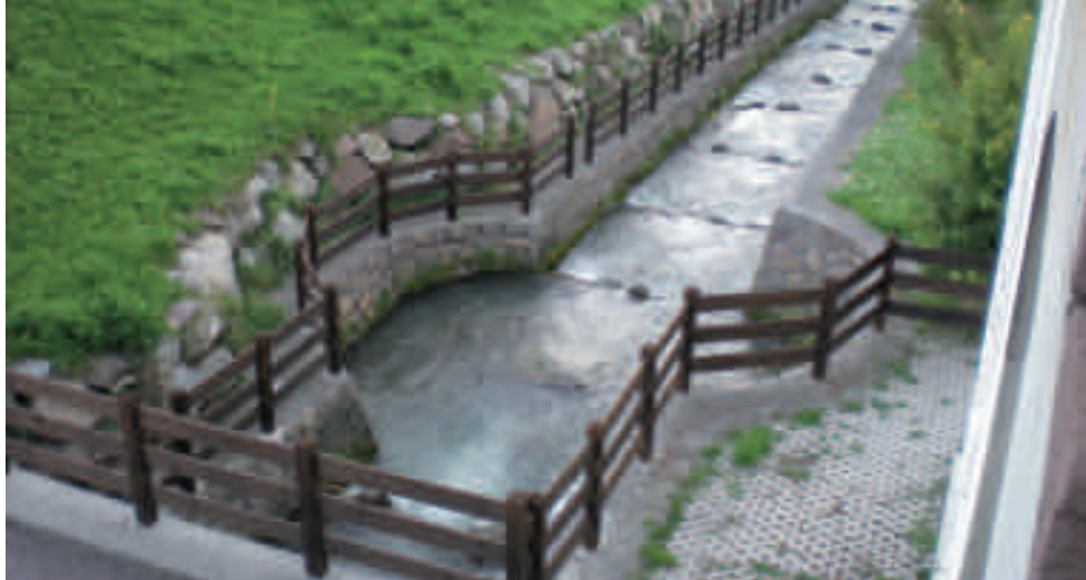
Impianto di risalita dei pesci della centrale idroelettrica "Claudio Castellani" nella Bassa Valle Isarco
