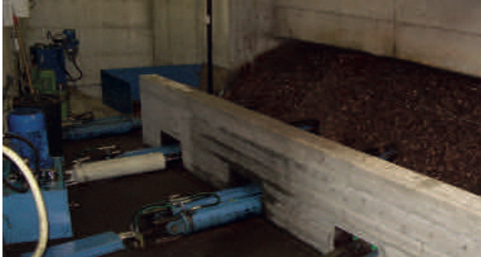
Lavorazione del cippato per biomasse
