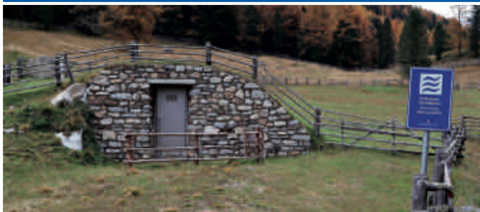
Centrale idroelettrica Teodone - Sorgente Steinwiesen esterno
