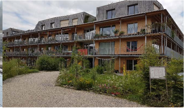
Abbildung 28: Ansicht von Gebäude B mit Einzeldächer 1-3
