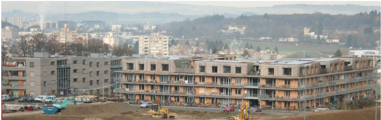
Abbildung 29: Übersicht der Überbauung Oberfeld, im Vordergrund Gebäude B, im linken Bereich Gebäude C
