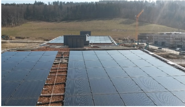
Abbildung 27: PVT Kollektorfelder auf Gebäude C
