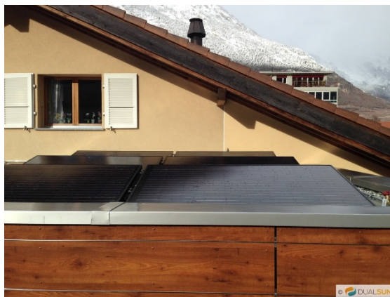
Abbildung 51: Anlage in Saxon zur solaren Brauchwarmwassererwärmung und entsprechendes Prinzipschema (Bilder: DualSun).
