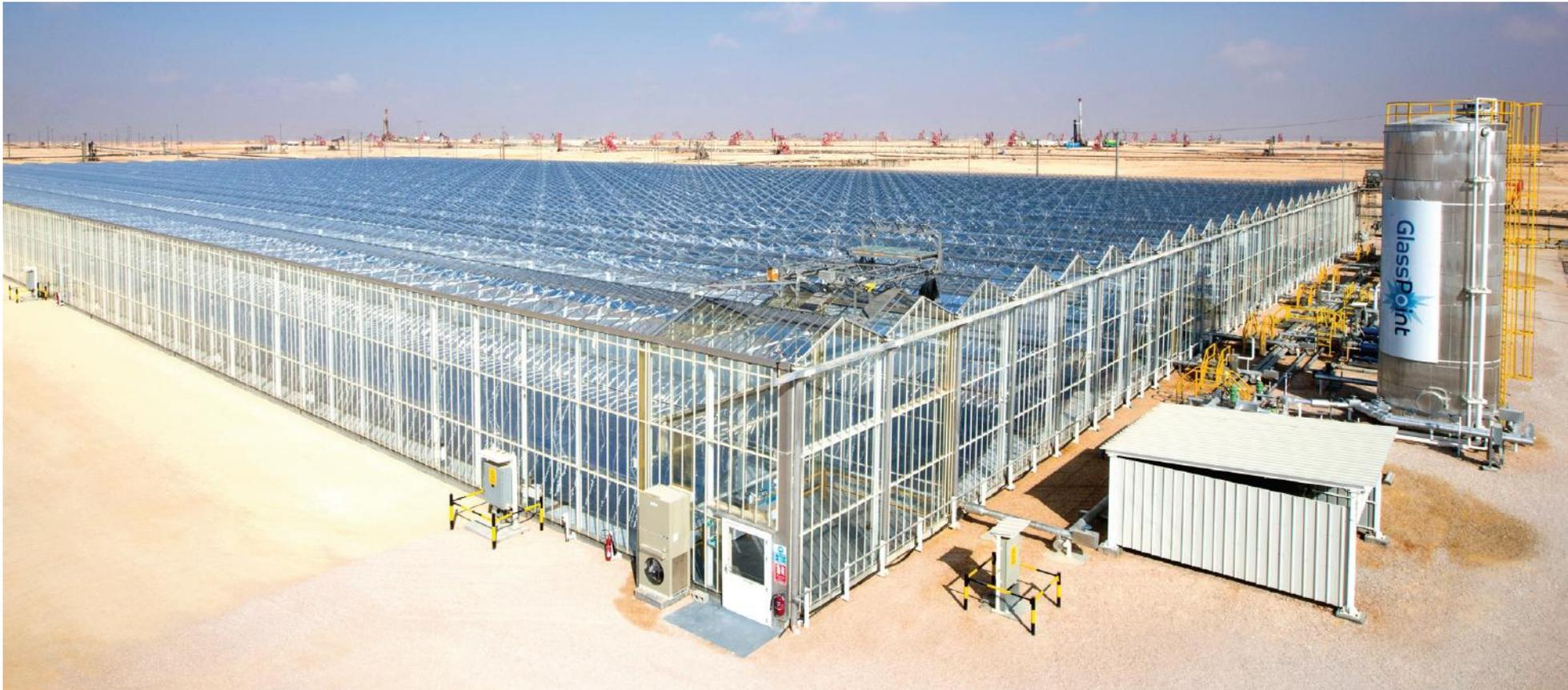
Investissement à hauteur du Gigawatt: Petroleum Development Oman investit USD 600 Million dans une centrale vapeur de  $1 \text{ GW}_{\text{th}}$  avec des capteurs paraboliques concentrés situés dans 36 serres modulaires. 6 000 tonnes de vapeur solaire produit quotidiennement à partir de 2017 afin de chauffer le pétrole brut dans le sol et ainsi le pomper plus facilement.
