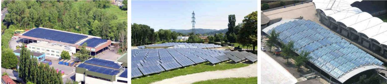
Abbildung 37: Thermische Solaranlagen gekoppelt an die städtische Fernwärme in Graz (von links: Fernheizwerk AEVG: 4.960 m<sup>2</sup>; Wasserwerk Andritz: 3.855 m<sup>2</sup>, UPC Arena: 1.407 m<sup>2</sup>) [www.solid.at]
