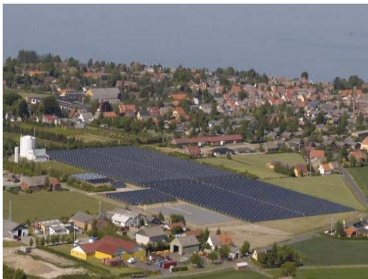
Abbildung 18: Die weltgrößte thermische Solaranlage in Marstal (DK) liefert mit einer installierten Leistung von 12,9 MW<sub>th</sub> 30% des Wärmebedarfs der Insel. (Quelle: Arcon, DK)
