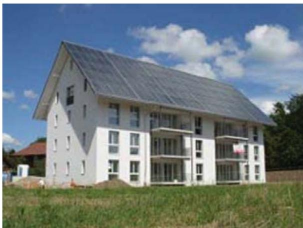
*Abbildung 16: 100% solar beheiztes Mehrfamilienhaus in der Schweiz mit 193 kW<sub>th</sub> installierter Leistung und 205 m<sup>3</sup> Wärmespeicher*
