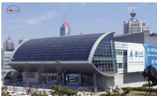
Abbildung 36: Lieferung und Montage von 1.300 m<sup>2</sup> Kollektorfläche zur Beheizung des Sport- und Trainingszentrums für das olympische Dorf in Qintao (China) durch das Grazer Unternehmen S.O.L.I.D.
