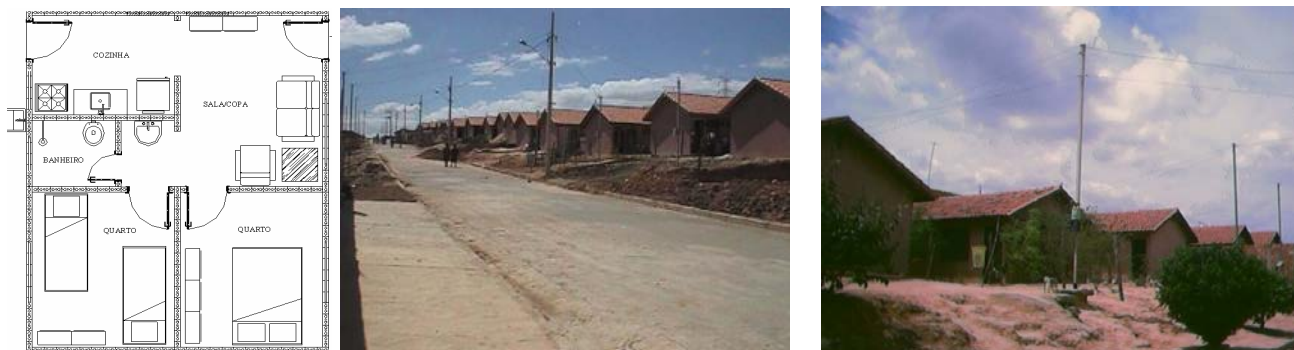
Figura 5.4 O projeto padrão e as moradias construídas no Bairro Sapucaias em Contagem (MG) em 1999. Fonte: Pereira et al., 2003b. Foto à direita, o núcleo em 2003. Foto: A autora, nov 2003.
