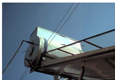
Figura 5.28 Sombreamento na placa por muro lateral e estrutura de arame sobre a placa
