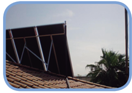
Figura 5. Colectores solares no integrados en cubierta inclinada
