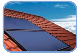
Figura 6. Colectores solares perfectamente integrados en cubierta inclinada
