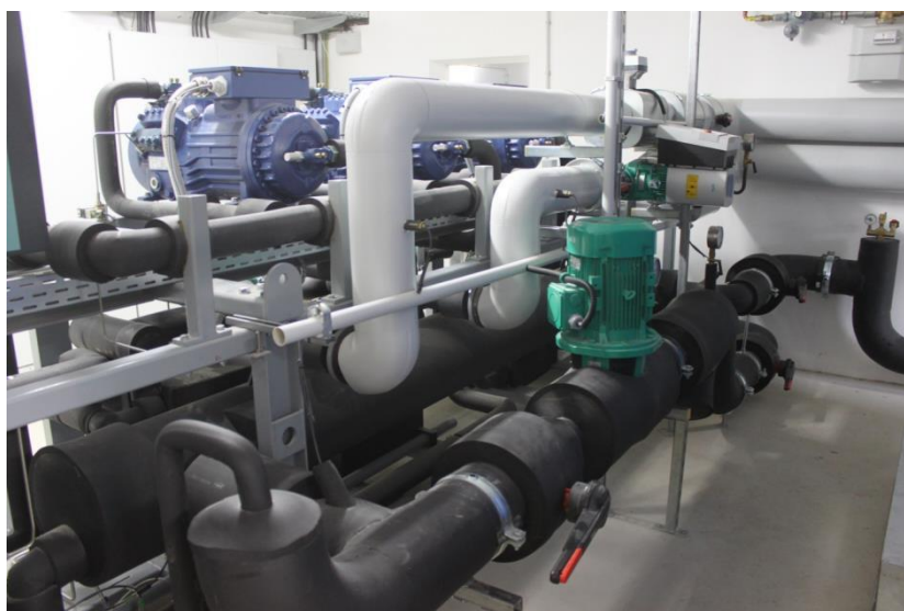
Slika 34. Dizalica topline koja koristi podzemne vode kao izvor topline (instalirana snaga 440 kW) u malom CTS sa solarnim kolektorima u Dollnsteinu, Njemačka (Izvor: Rutz D.)
