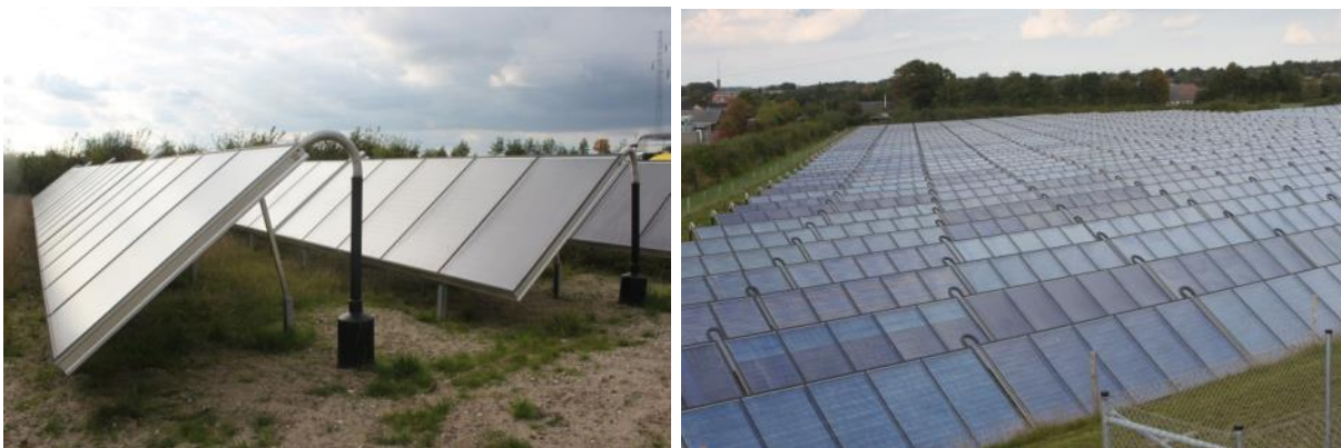
Slika 8. Pločasti kolektori postavljeni na zemlju koji su dio CTS-a u Gramu u Danskoj (Izvor: Rutz D.)
