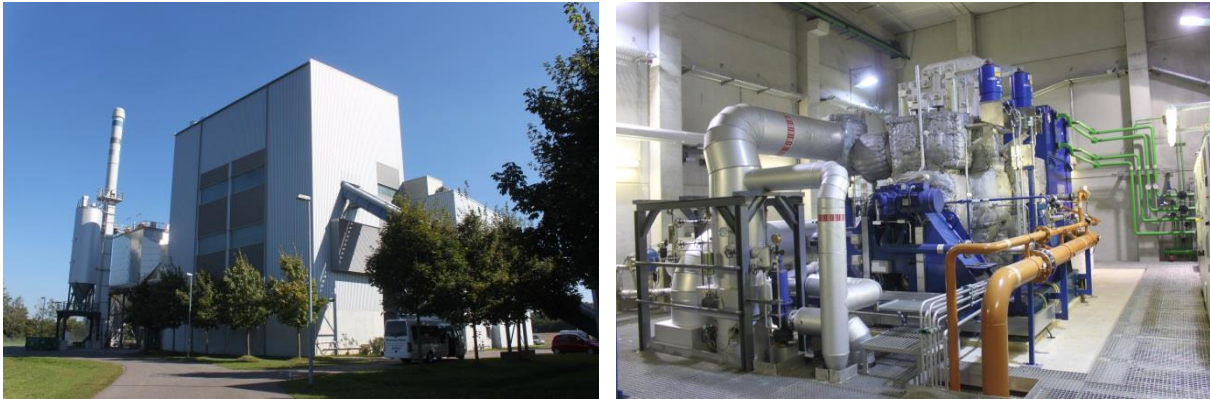
Slika 19. Kogeneracijsko postrojenja na drvenu sječku, te parna turbina postrojenja Stadtwerke Augsburg Energie GmbH u Njemačkoj (kapacitet 80 000 t/god drvene sječke; 7,8 MW el ; 15 MW th ) (Izvor: Rutz D.)
