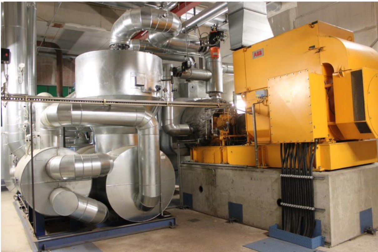
Slika 20. ORC sistem (1 520 kW el ) u Grünfütterrocknungsgenossenschaft Kirchdorf a.H. eG u Njemačkoj (Izvor: Rutz D.)
