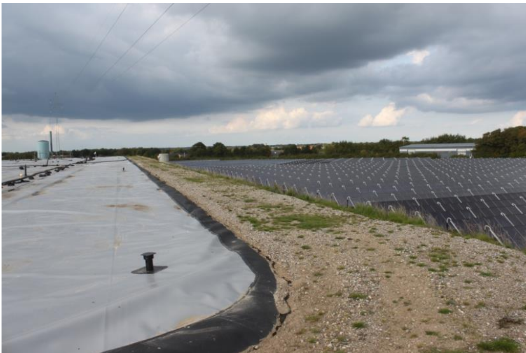
Slika 45. Uvećani prikaz rubnog dijela toplinskog spremnika u obliku izolirane jame u sklopu solarnog CTS-a u Gram, Danska (Izvor: Rutz D.)
