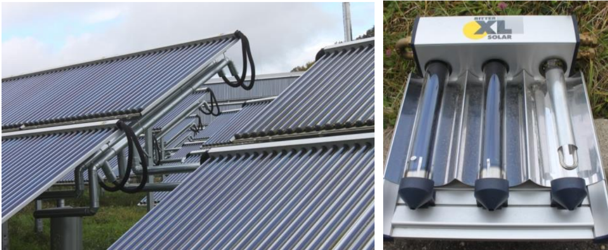
Slika 7. Vakuumski kolektori postavljeni na zemlju (lijevo) koji su dio CTS-a u Bisingenu u Njemačkoj te uzorak ove vrste kolektora (desno) koji prikazuje U cijev u desnoj cijevi, kao i složeni parabolični koncentrirajući kolektor (eng. Compound Parabolic Concentrator - CPC) (Izvor: Rutz D.)
