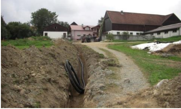
Slika 52 Ugradnja cijevi za CTS na selu (Izvor: Thermaflex Isolierprodukte GmbH)
