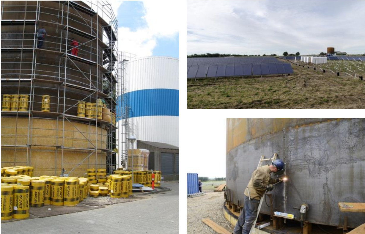
Slika 43. Izgradnja dva nova toplinska spremnika u obliku čeličnog tanka u CTS-u Hjallerup (lijevo) i izgradnja iste vrste spremnika topline povezanog sa solarnim kolektorima i kotlom na slamu. Više o CTS-u u Hjallerupu se može saznati u izvještaju o primjerima najbolje prakse Laurberg Jensen et al.(2016) (Izvor: http://www.hjallerupfjernvarme.dk )
