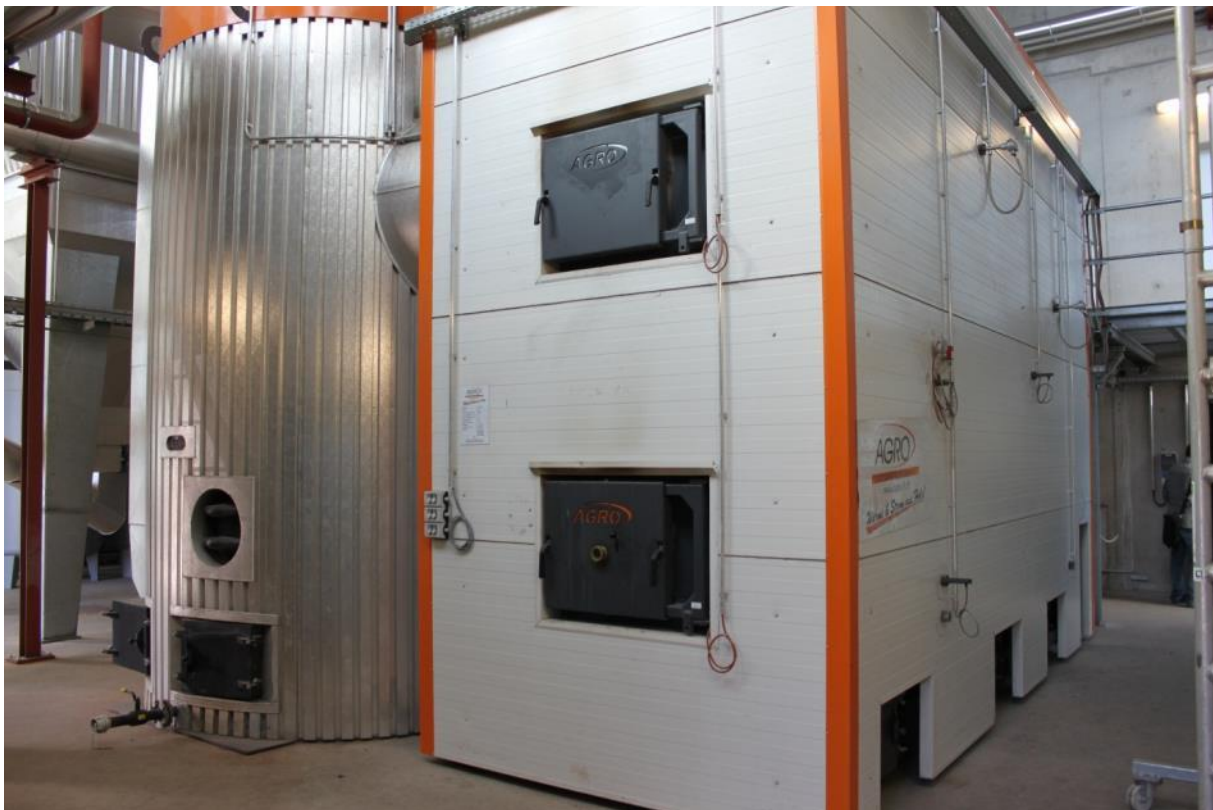
Slika 16. Sistem grijanja srednje snage (instalirana snaga 3 000 kW) sa kotlom (desno) i spremnikom topline (lijevo) u Njemačkoj - Biomassehof Achental (Izvor: Rutz D.)
