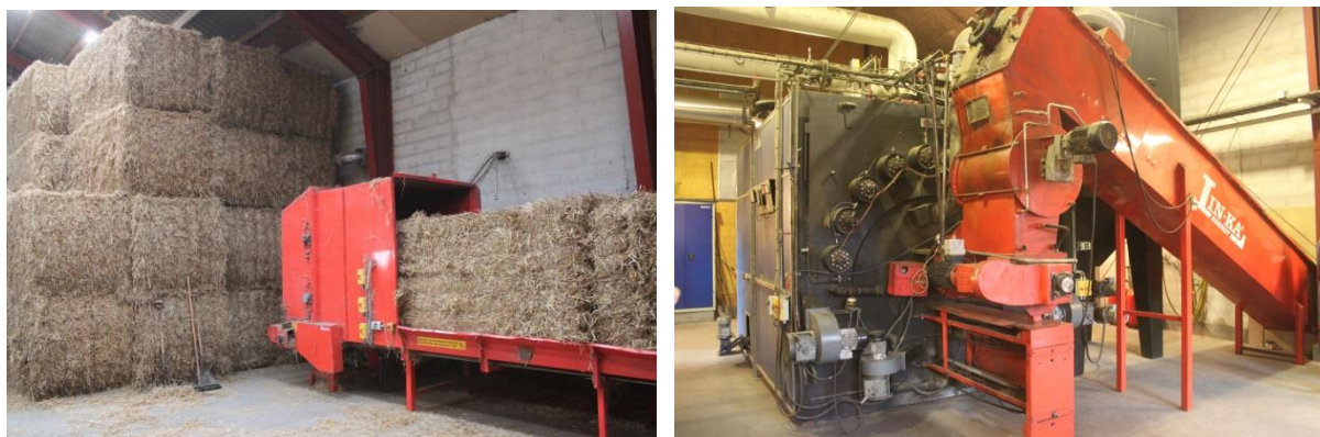
Slika 17. Sistem za dobavu bala slame (lijevo), te kotao na slamu snage 1,6 MW u in Ballen-Brundbyu, Danska (Izvor: Rutz D.)
