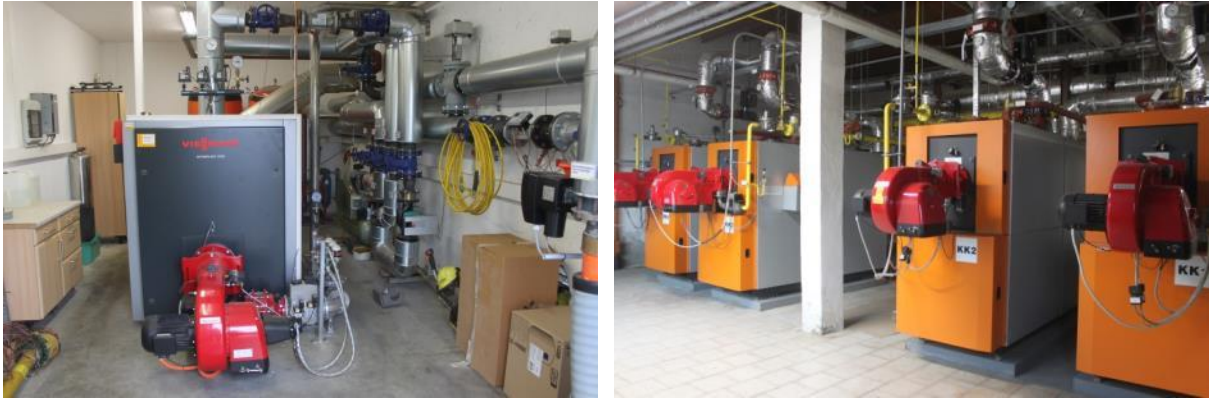
Slika 40. Vršni kotao na lož ulje u sklopu bioplinskog postrojenja u Njemačkoj (lijevo) te plinski kotlovi (desno) u sklopu postrojenja na biomasu u Češkoj (Izvor: Rutz D.)
