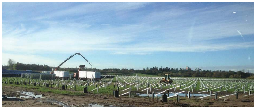
Монтаж на ново слънчево поле. Монтажът на един панел отнема десет минути
