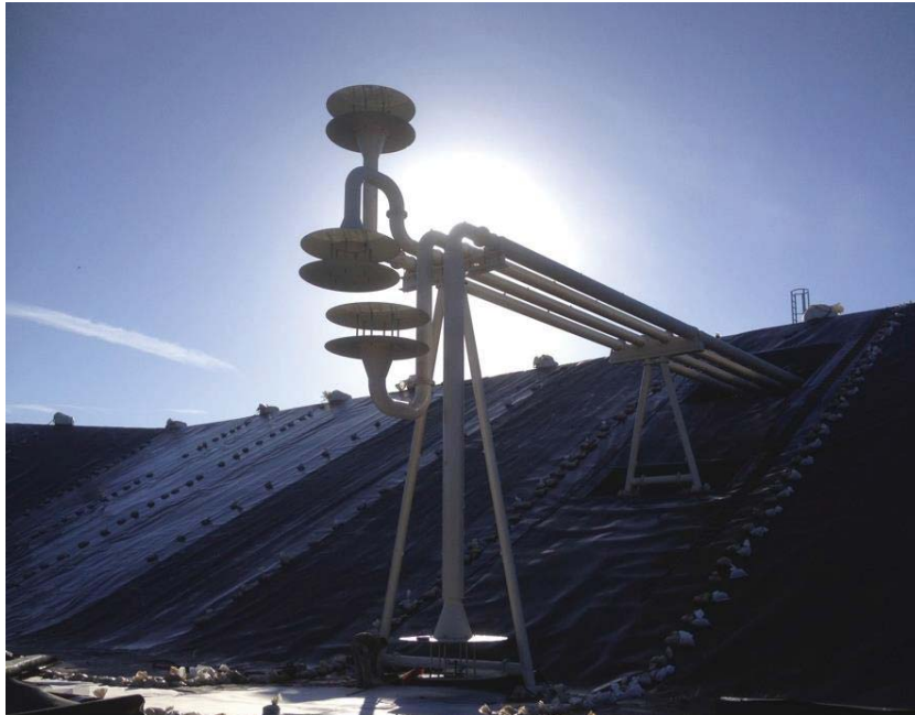
Дистрибутираща система за подаване на гореща вода в различните слоеве на водния обем
