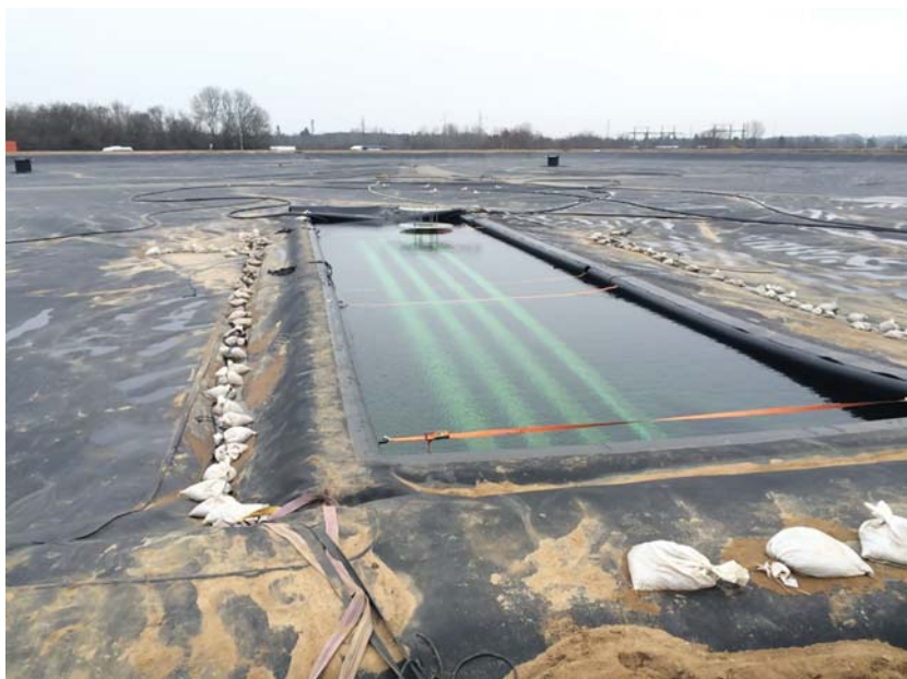
Буферът след напълване с вода в зоната на дистрибутиращата система
