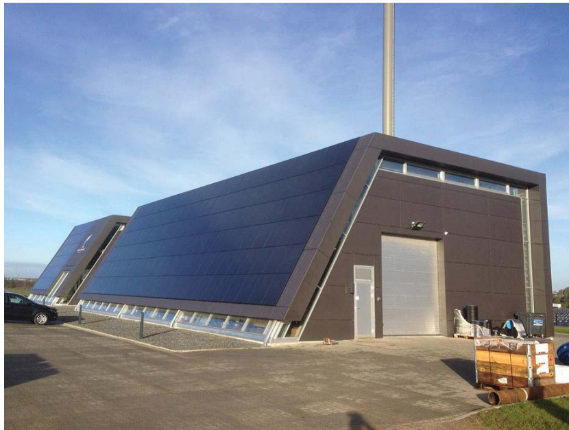
Сградата на топлоцентралата. Фасадата е с вградена фотоволтаика, като произведената енергия е достатъчна за циркулационните помпи. 240 m 2 фотоволтаика произвеждат 26 MWh/година
