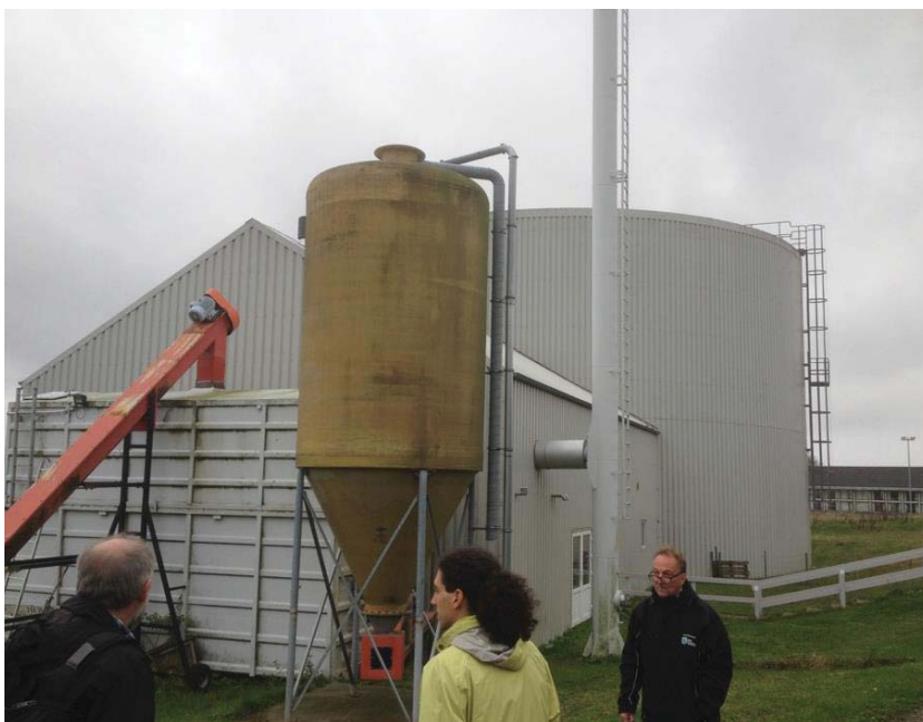
Топлоцентралата е автоматична и се посещава само при необходимост
