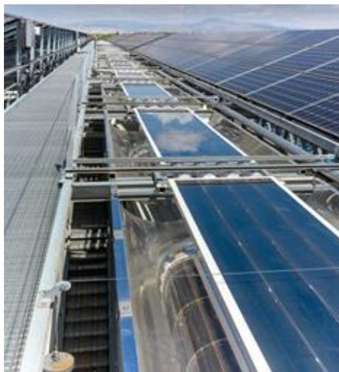
Figura 5.19. Instalación de captadores de tubos de vacío, farmacéutica HEFAME.
