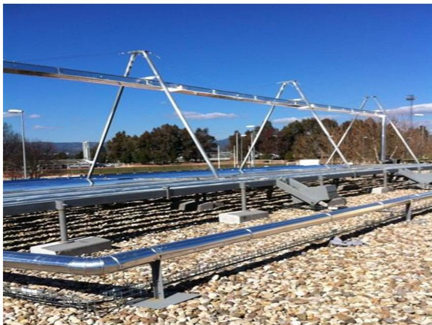
Figura 5.9. Instalación de concentrador lineal Fresnel, Córdoba, España.
