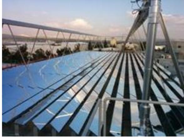
Figura 5.10. Instalación de concentrador lineal Fresnel, RAM Pharma, Sahab.
