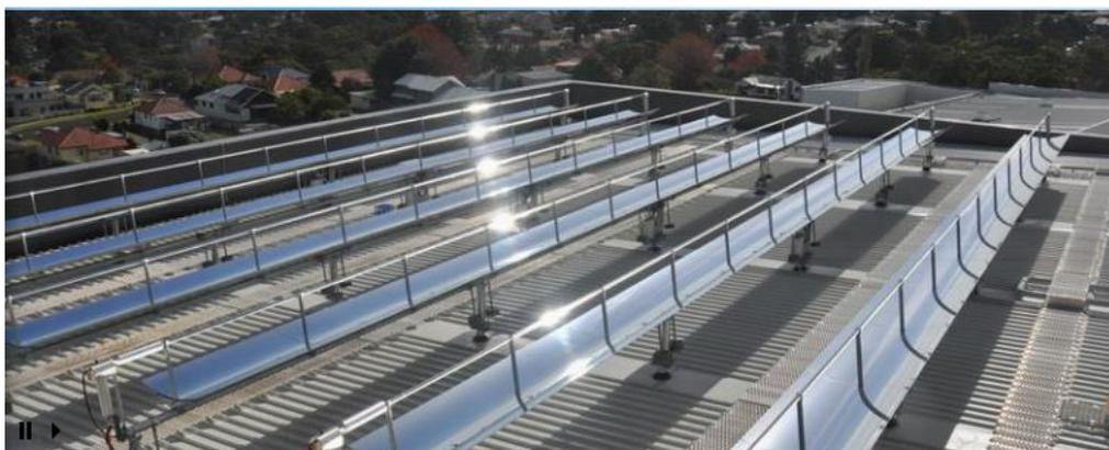
Figura 5.3. Canal parabólico NEP SOLAR
