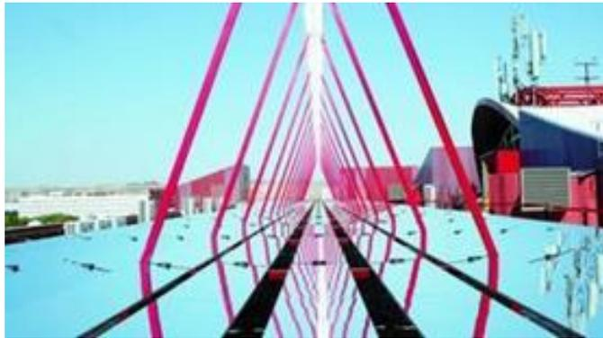
Figura 5.7. Instalación de concentrador lineal Fresnel, Escuela Técnica Superior de Ingenieros, Sevilla.
