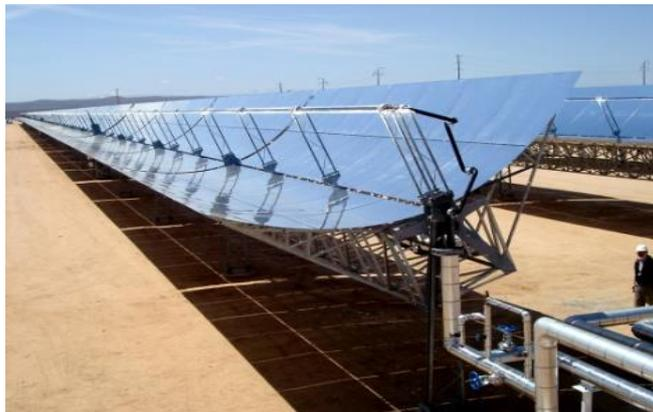
Figura 5.14. Instalación de canal parabólico, Minera El Tesoro, Chile.
