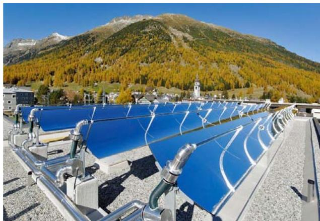
Figura 5.15. Instalación de canal parabólico, LESA, Engadin.
