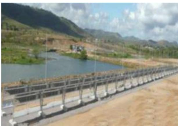
Figura 5.13. Instalación de canal parabólico, Kraft Food, Recife.
