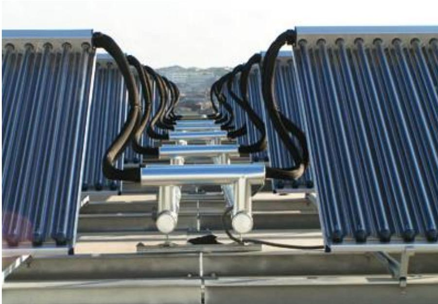
Figura 5.5. Captadores de tubos de vacío
