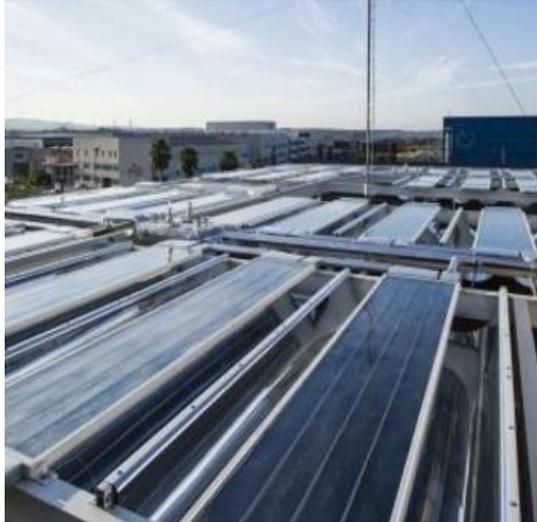
Figura 5.18. Instalación de captadores de tubos de vacío, aeropuerto de Ginebra.
