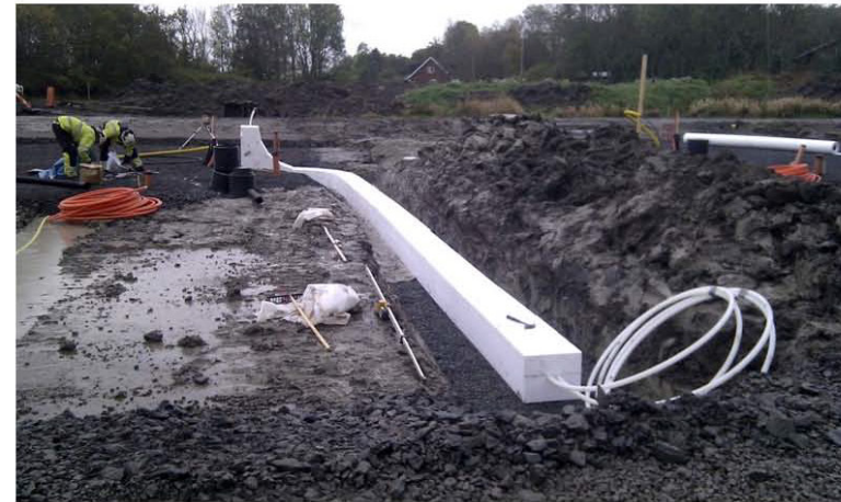
Sek.kulvert (plaströrskulvert) fram till villa
