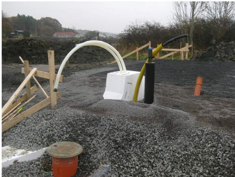
UC2 – Primärvärme- och sek.kulvert samt kallvatten in i UC
